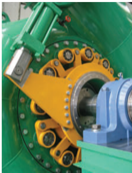
Dettaglio di una turbina Francis ad asse orizzontale
